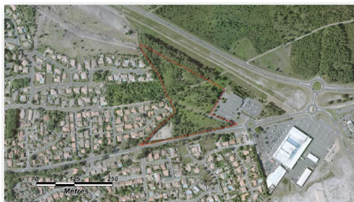
Vue aérienne du site Avenue de Bordeaux
