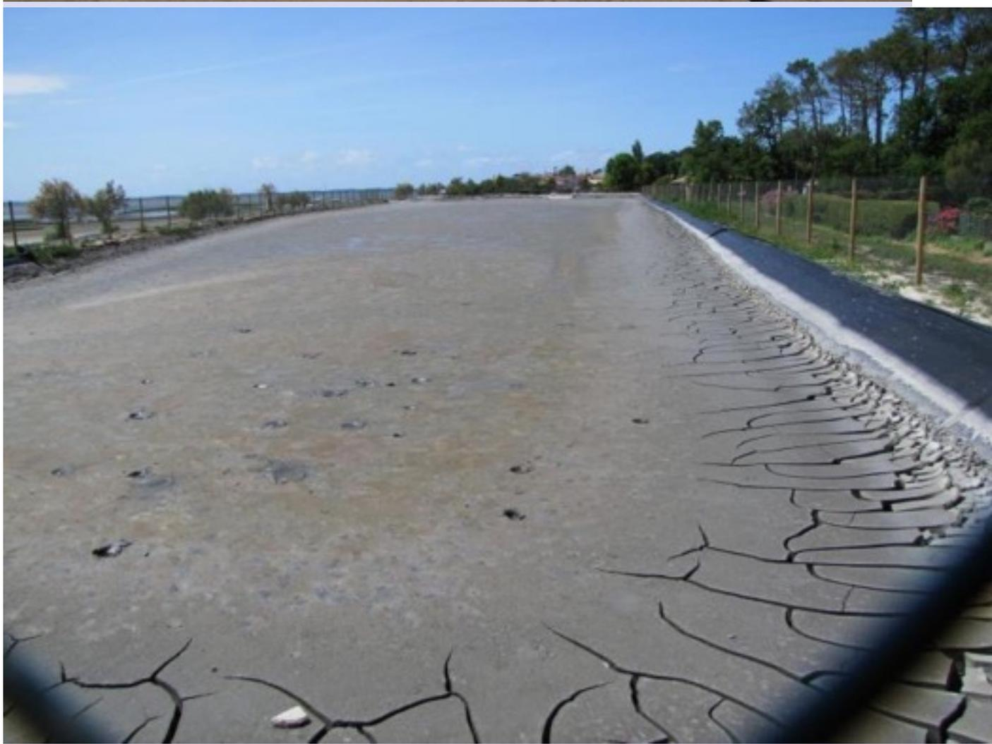
L'autre technique, la 2, c'est le dragage mécanique. Lorsqu'on n'a pas ou ne peut pas faire de bassin de décantation, la solution consiste à fermer l'entrée du port et à laisser les vases s'assécher.
